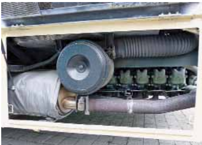
Um den Feinstaubausstoß zu reduzieren, haben die SWT ihrem Oldie einen Baumot-Filter nachgerüstet. Er ist hinten links verbaut.
